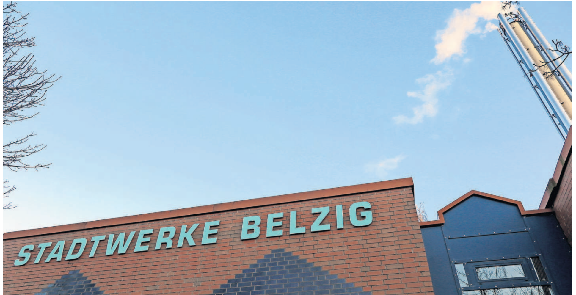
Die Stadtwerke Bad Belzig GmbH betreibt das Heizwerk Klinkgrund in Bad Belzig.
