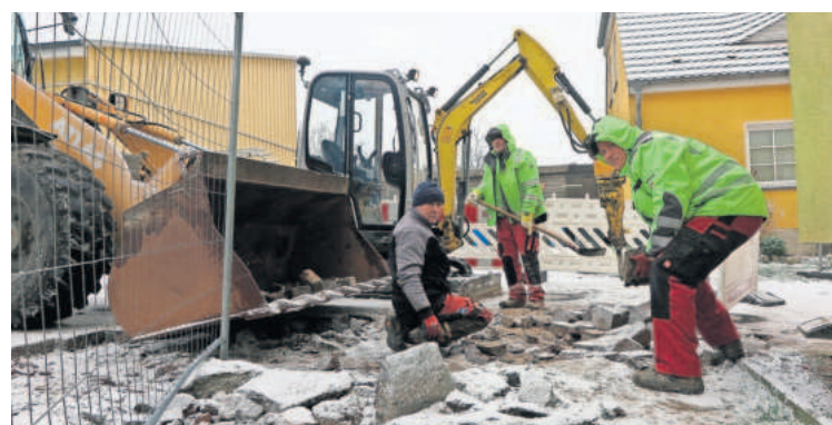
Vor den Wohnblöcken auf dem Wiesenburger Holzhof werden Regen- und Abwasserkanal verlegt und dann die Straße gepflastert. FOTO: RG
