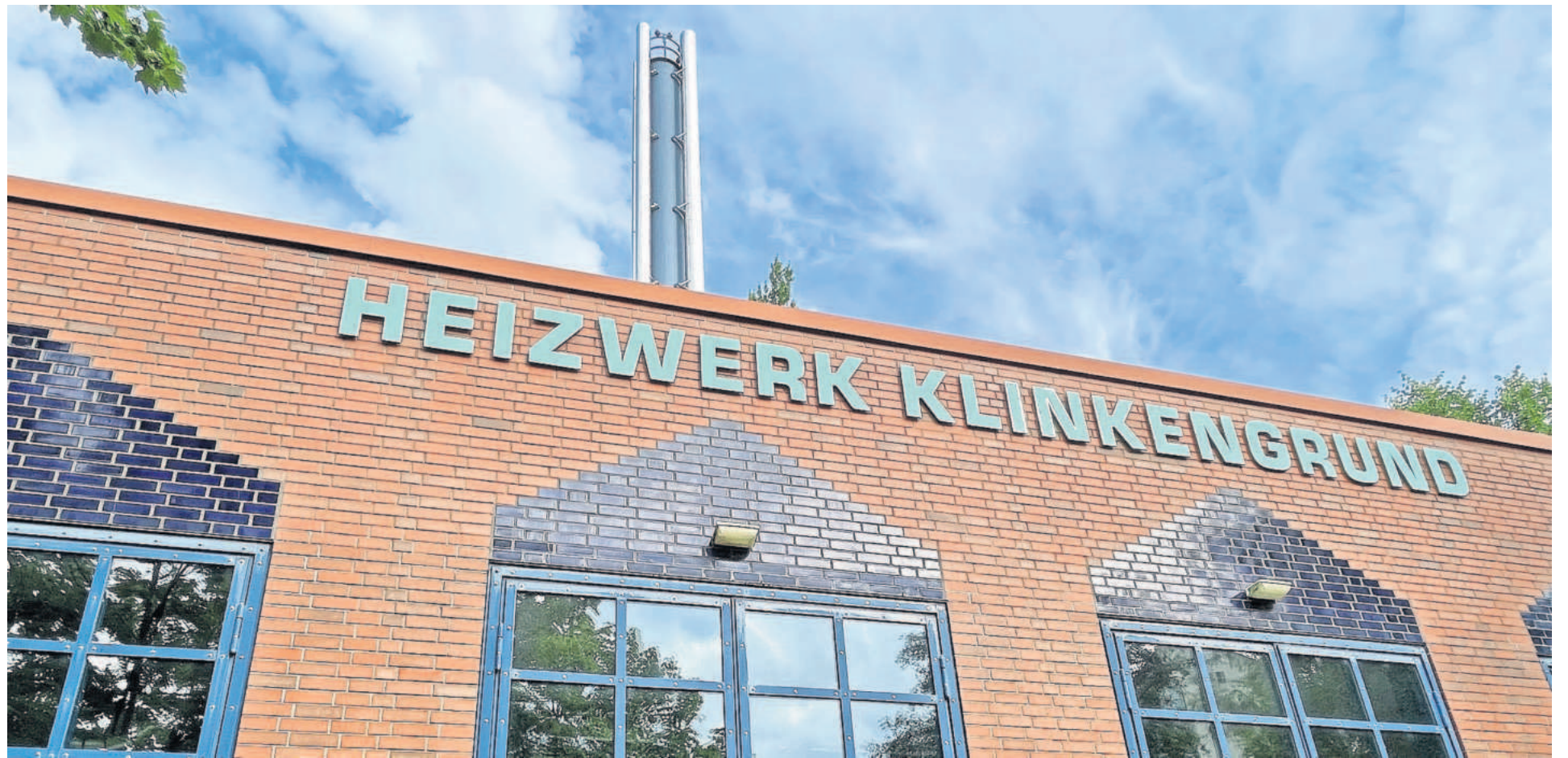
Die Stadtwerke Bad Belzig GmbH betreibt das Heizwerk Klinkengrund.
