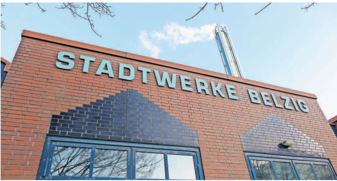
Die Stadtwerke Bad Belzig GmbH betreibt das Heizwerk Klinkengrund. FOTO: HERMANN M. SCHRÖDER
