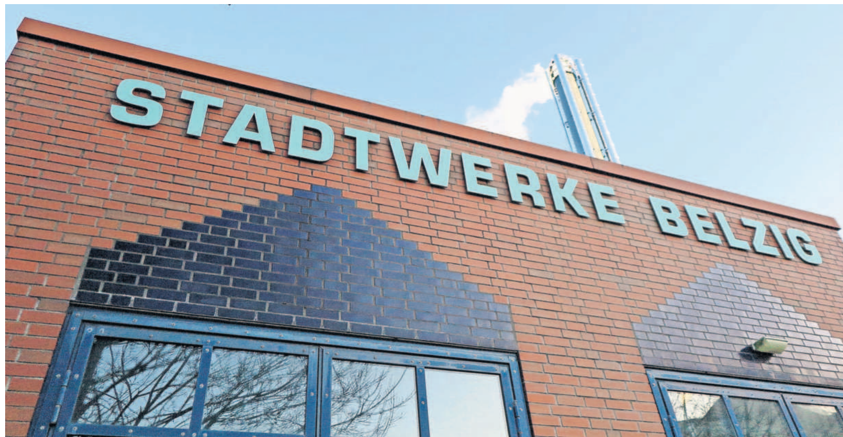
Die Stadtwerke Bad Belzig GmbH betreibt das Heizwerk Klinkengrund in Bad Belzig.
